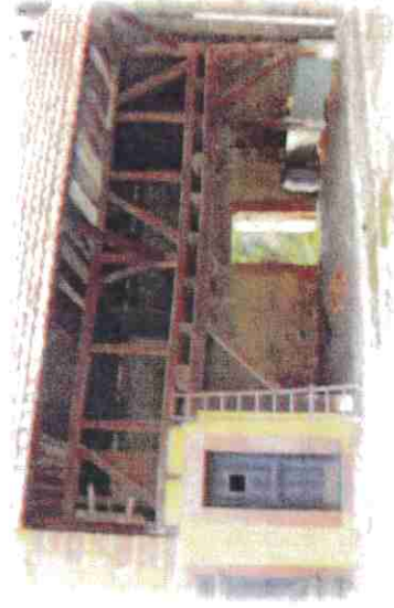
Figure 9 : Abri devant être démolie
